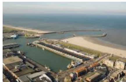
Noordelijk Havenhoofd huidige situatie
