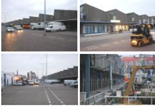
Schamhart gebouw – bestaande situatie
