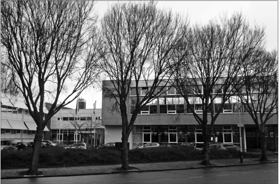
Dit vertrouwde beeld van het HALO-complex ondergaat vanaf komend najaar een metamorfose: sloop, braakliggend terrein en vervolgens de bouw van een appartementencomplex.
