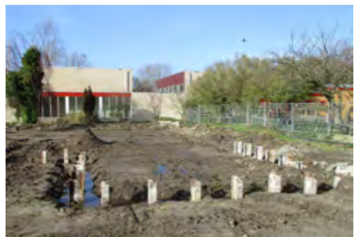
In een hoek van het bouwterrein zijn de contouren al zichtbaar van de plek waar de automatische autolift naar de toekomstige parkeergarage wordt ingebouwd.
