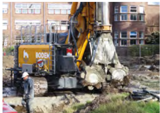
De raderen van de CSM-freesmachine
