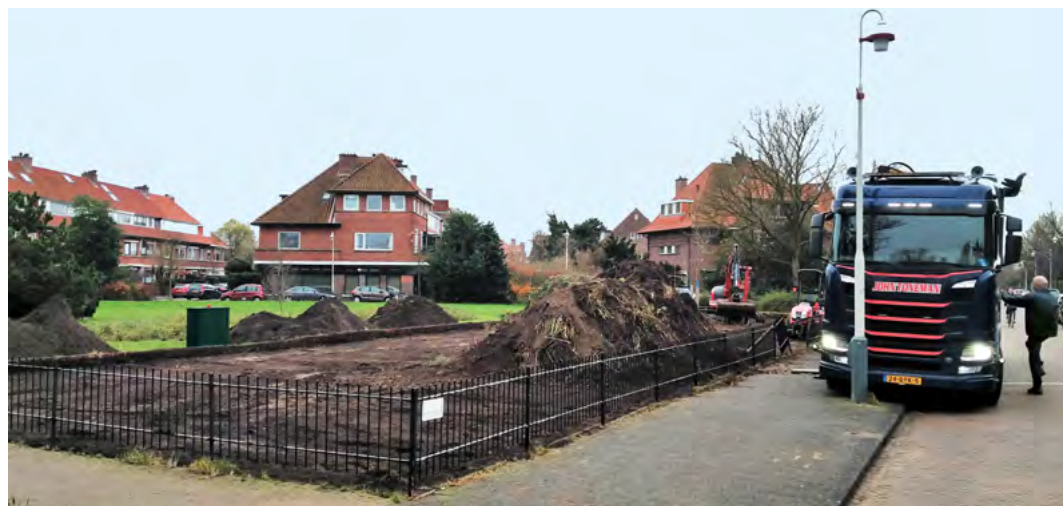
Afvoer van beplanting en bovenste laag aarde op het Fazantplein
