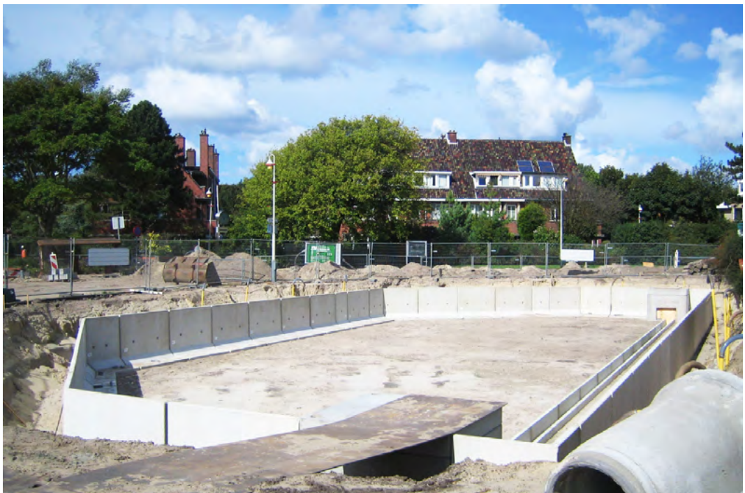
Aanleg van een ondergronds opvangbassin voor hemelwater op het Eiberplein
