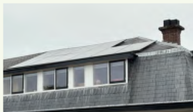
Het plaatsen van zonnepanelen op het leien dak ging niet van een leien dakje.
