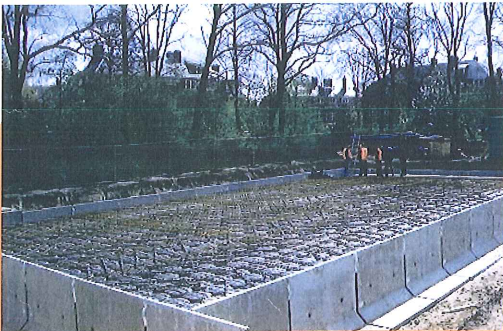
Figuur 3: Aanleg infiltratievoorzieningen in de Vogelwijk.
