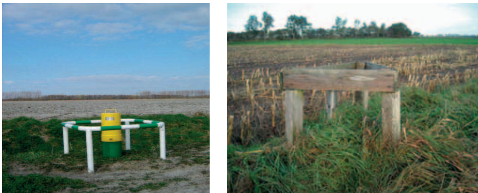
FIGUUR 3.4 ONDERTEGEL (MIDDEN EN RECHTS) EN BOVENTEGEL (LINKS) BIJ EEN STRAATPOT (BRON: PROVINCIE FRYSLÂN)
