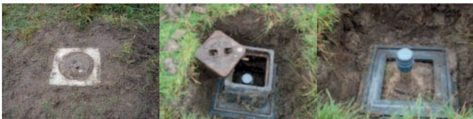
FIGUUR 3.4 ONDERTEGEL (MIDDEN EN RECHTS) EN BOVENTEGEL (LINKS) BIJ EEN STRAATPOT (BRON: PROVINCIE FRYSLÂN)
