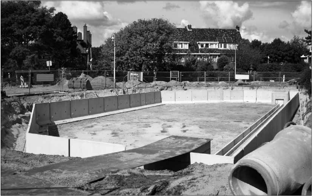
De aanleg van een opvangbassin voor regenwater onder het Eiberplein.
