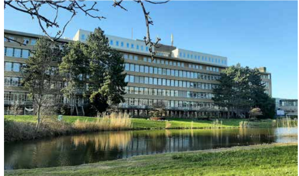
Beddenhuis: een dakopbouw kan de latere opbouw vervangen
