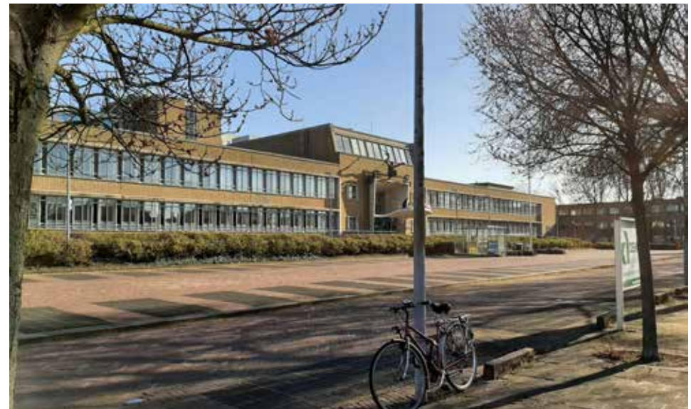
Polikliniek: een dakopbouw is voorstelbaar mits deze voortbouwt op de bestaande onderbouw en de monumentale entreepartij
