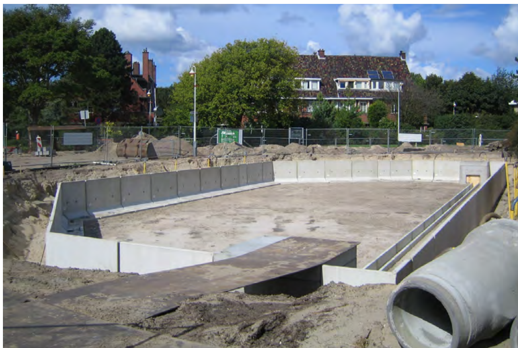
Aanleg van een ondergronds regenopvangbassin onder het Eiberplein in 2012
